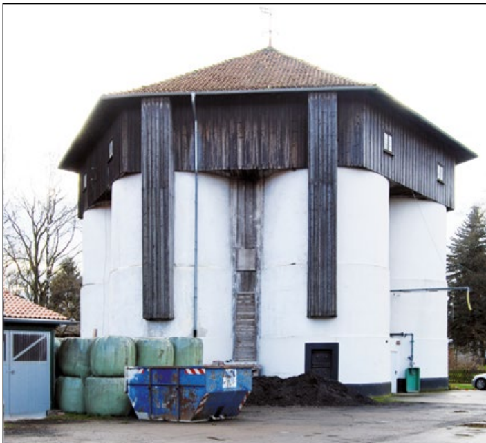
So sah das Großsilo in Marienburg vor der Dachabdeckung aus.
